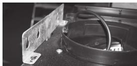
**2. Установка вытяжки.** Закрепите вытяжку на крепежной пластине при помощи креплений идущих в комплекте. Убедитесь что все крепежные элементы зафиксированы.
