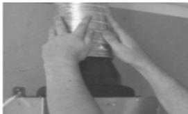
4. Подключите одну часть алюминиевой трубы к вытяжке, другую часть трубы выведите в вентиляцию, так же см. раздел «Рециркуляция воздуха».
